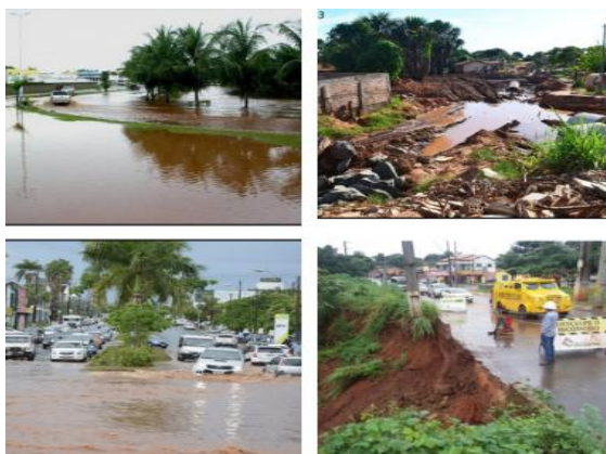
Figura 1. Condições estruturais e alagamentos no Córrego Neblina antes das intervenções.
